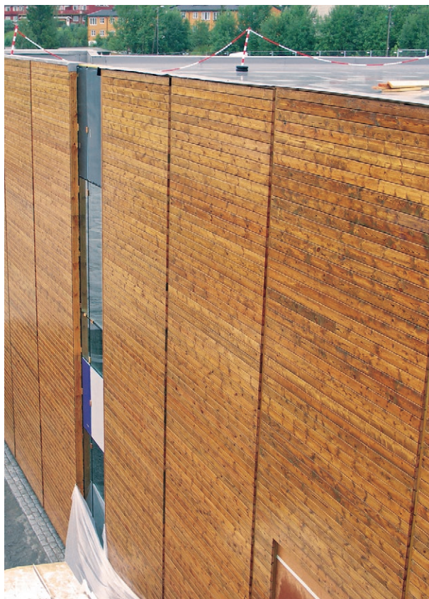
Vägg med fasadmaterial, trätrall
